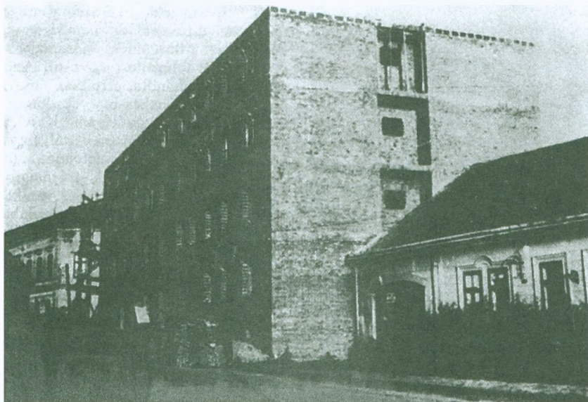
Az épülő posta melletti lakóház építés a Zrínyi Miklós utca felől
