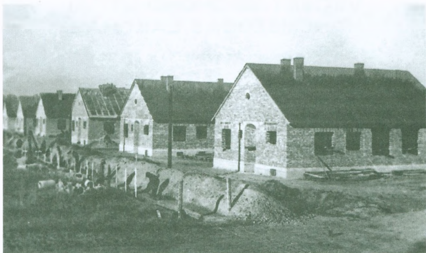
Az Olaj utcai lakások az építkezés alatt
