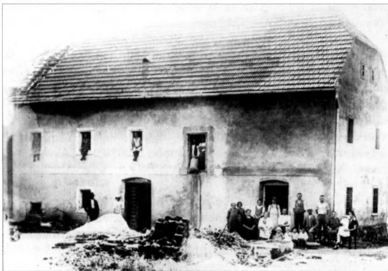
79. A dömeföldi Fata-malom 1927-ben, átépítés közben
