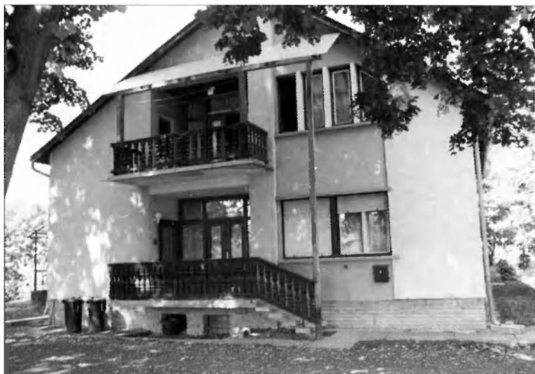
159. A Plébánia mai épülete
