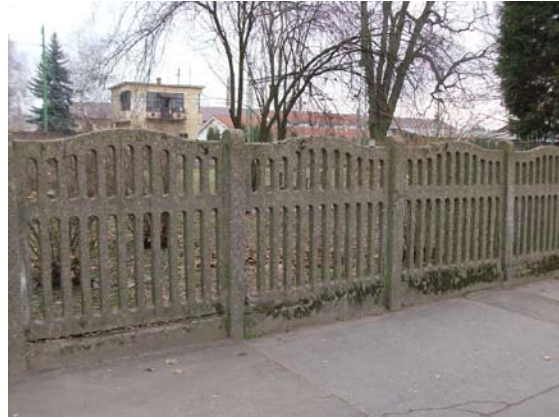
Betonból öntött kerítés az épület déli oldalán
