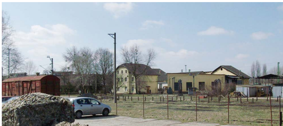
Az épületegyüttes északkeletről
