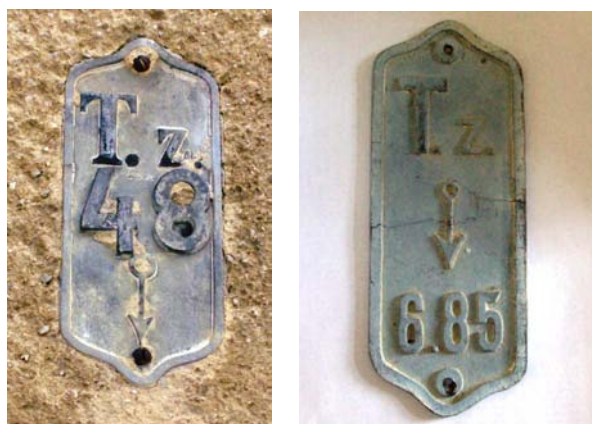
A hálózat bővítése során használt, tolózárat jelző táblák
