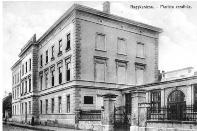
Az utcai épület az átépítés után
